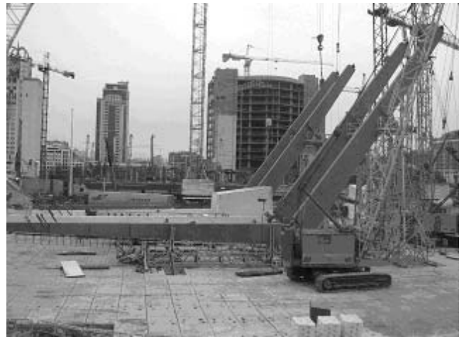
Рисунок 8. Загальний вигляд розміщення колон на стенді
