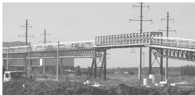
Рисунок 1. Участок КЛК с мостовым переходом
